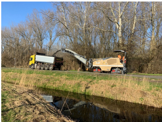
Reparatie van het parcours.
